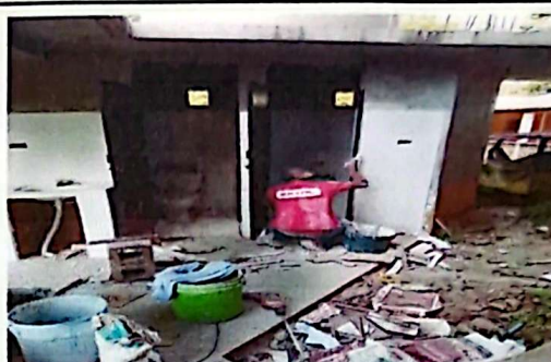
Foto 2: colocacion de azulo en los baños
