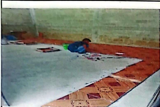
Foto1: inicio colocacion de piso ceramico
