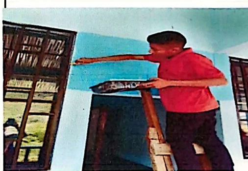
Foto 4: la pintada de paredes interior y exterior del edificio educativo del Instituto Telesecundaria aldea Cerro Lindo Cobán Alta Verapaz.
