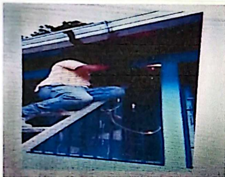
Foto 3: colocacion de balcones en las ventanas del Instituto
